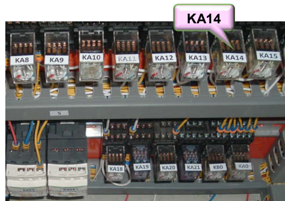
Hình 10.8: Kiểm tra rơ le trung gian KA14
